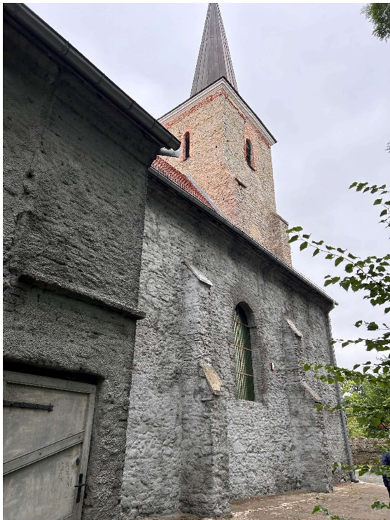
Fot.6. Elewacja północna -widok na wieżę Kościoła
