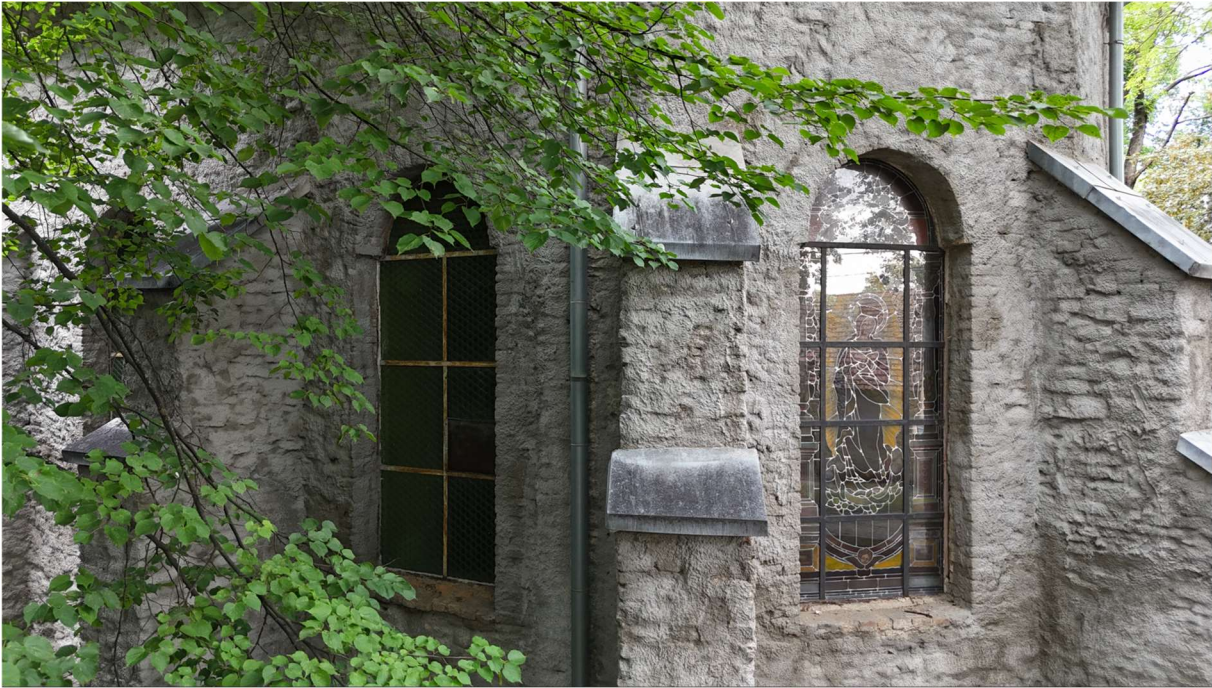
Fot. 26 Widok od strony wschodniej
