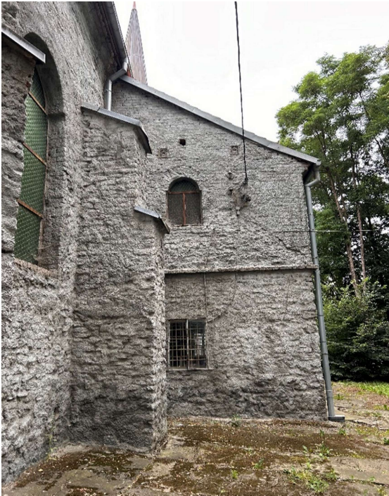
Fot. 8. Fragment elewacji bocznej- aneks dwukondygnacyjny
