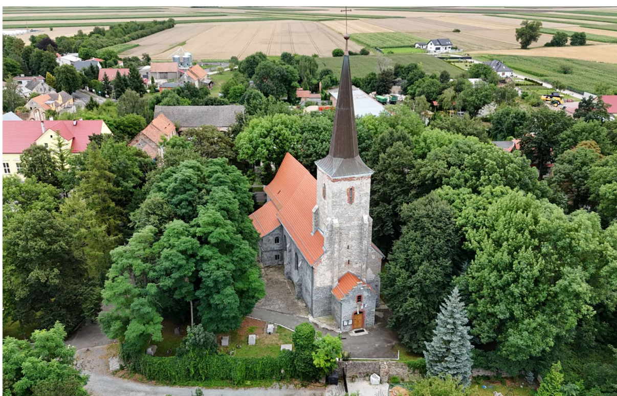
Fot. 4 Widok kościoła z lotu ptaka- elewacja zachodnia (wejściowa) z wieżą i kruchtą.
