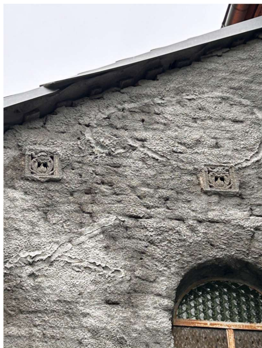
Fot. 16,17 widoczne uszkodzenia kapnika na przyporze oraz detale elewacji wymagające odczyszczenia i odmalowania
