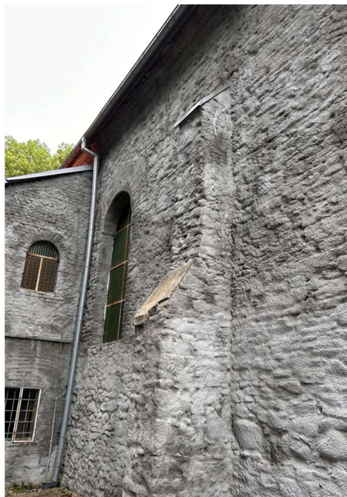
Fot. 14,15 widoczne znaczne uszkodzenia struktury gzymsów i kapnika przypory
