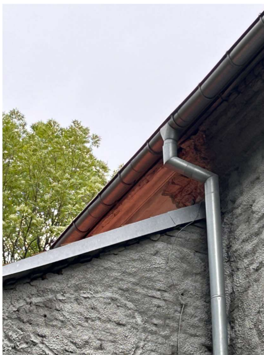
Fot. 14,15 widoczne znaczne uszkodzenia struktury gzymsów i kapnika przypory
