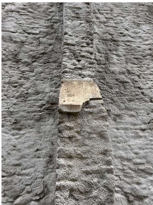
Fot. 16,17 widoczne uszkodzenia kapnika na przyporze oraz detale elewacji wymagające odczyszczenia i odmalowania
