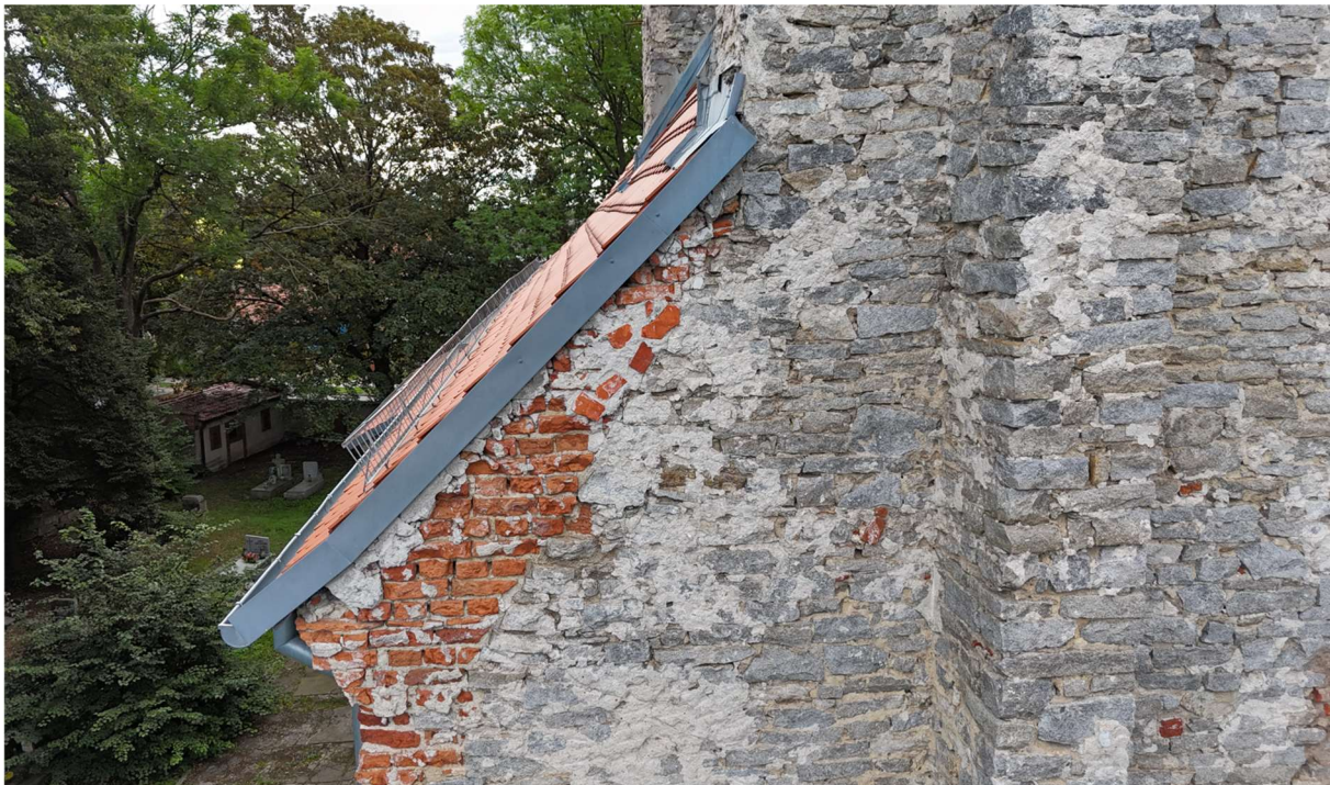
Fot. 19 Widok ściany kościoła od strony zachodniej- widoczna struktura ściany z granitu i cegły.
